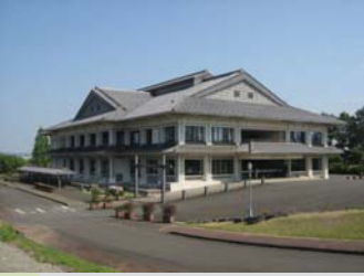
甘楽町文化会館
