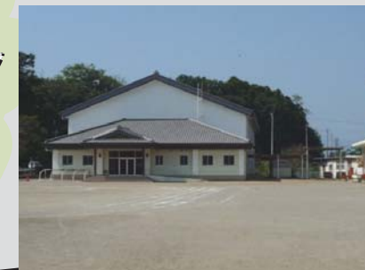
新屋小学校 体育館
