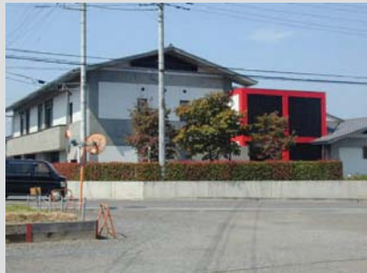
甘楽町図書館(ら・ら・かんら)
