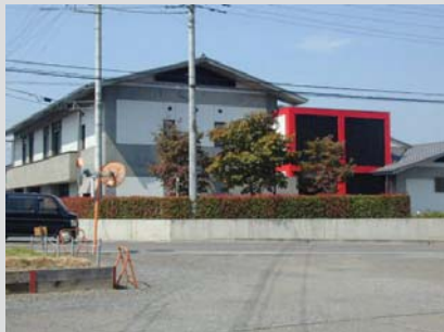
甘楽町図書館(ら・ら・かんら)
