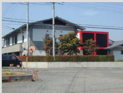
甘楽町図書館(ら・ら・かんら)
