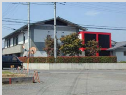
甘楽町図書館(ら・ら・かんら)
