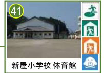
新屋小学校 体育館
