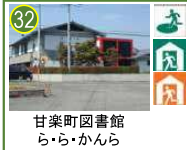
甘楽町図書館 ら・ら・かんら
