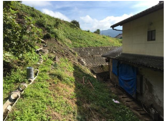
那須・住宅裏土砂崩れ
