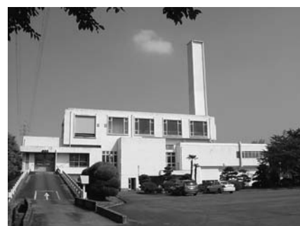
衛生管理センター（し尿処理施設）
