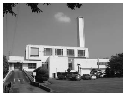
衛生管理センター（し尿処理施設）
