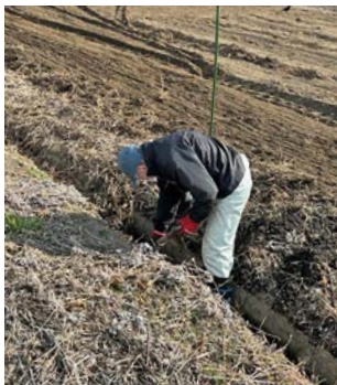
水路の掘り上げ作業
