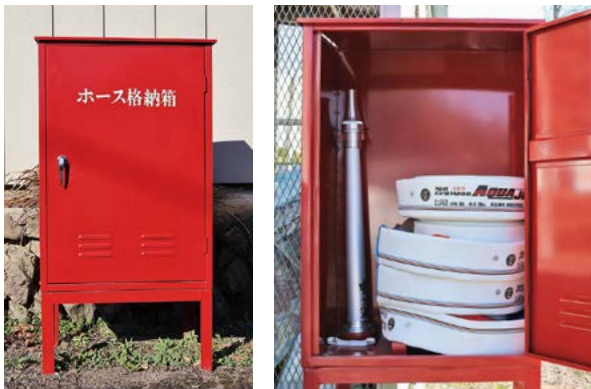
第6区に設置された消防ホース用格納庫(左写真)と消防ホース(右写真)
