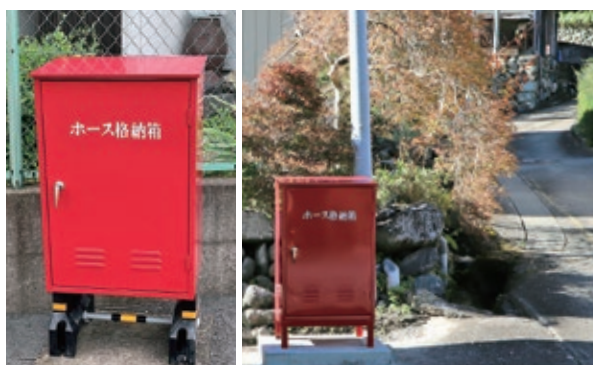
消防ホース用格納庫を設置した第23区(左写真)と第10区(右写真)
