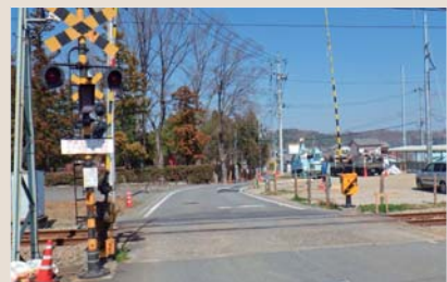
県道金井高崎線道路改良工事に伴い、新屋駅から堰口橋にかけて配水管の布設替工事を行います。
