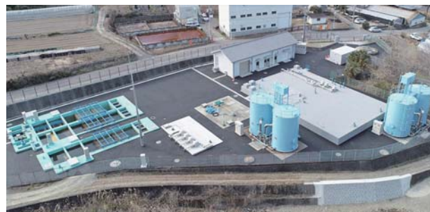
改修を終えた白倉浄水場
