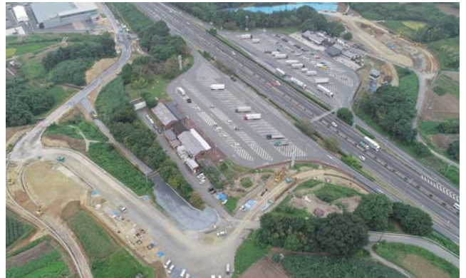
整備中の甘楽スマートインターチェンジ
