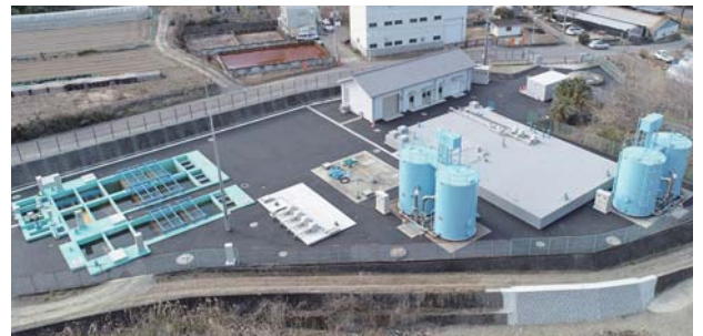
改修を終えた白倉浄水場
