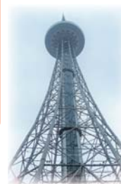
2000年完成 高さ336m
