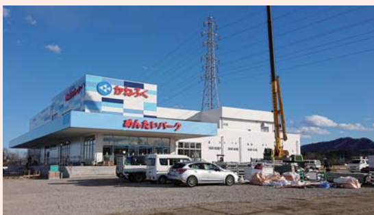
建設工事が進む「めんたいパーク群馬」
