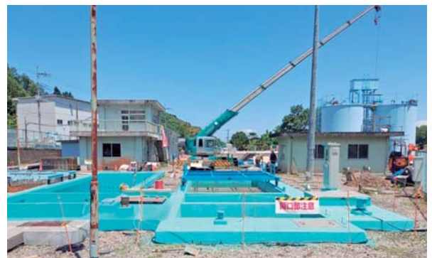
改修工事が進む白倉浄水場
