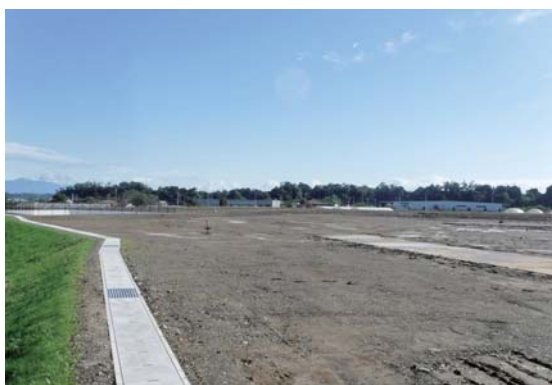
造成を終えた天引第三工業団地
