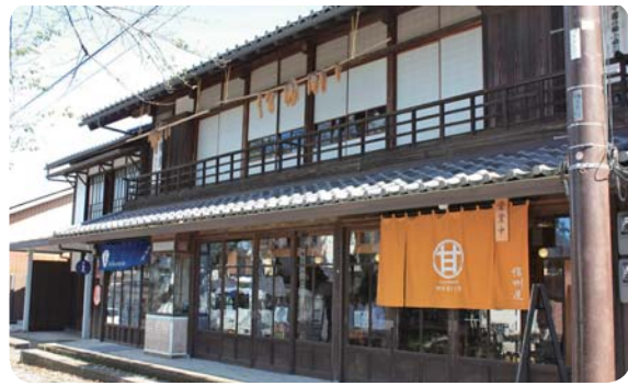
来訪者との交流を推進するため整備された歴史的建造物「信州屋」
