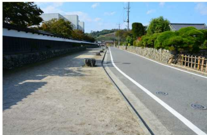
■電柱移転整備前の状況(御殿前通り)
