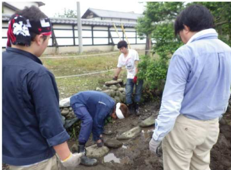
水路石積み補修作業 平成25年8月22日
