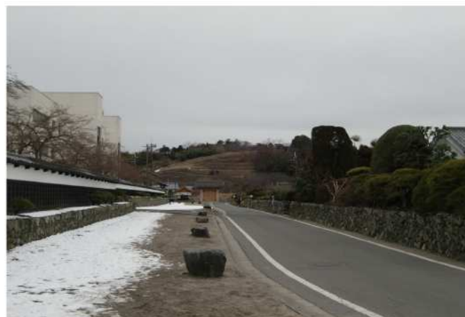
■電柱移転整備後の状況(御殿前通り)
