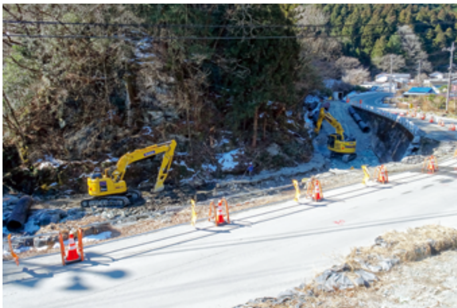
災害復旧工事が進む秋畑河振地区
