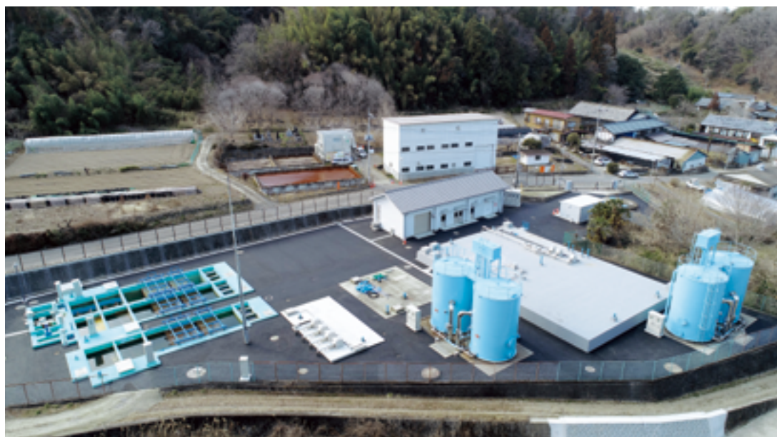
白倉第一浄水場
