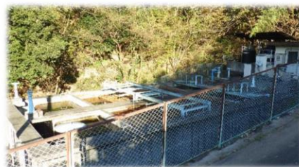
轟浄水場（沈殿池）
