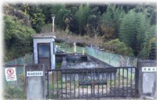
来波浄水場（沈殿池）
