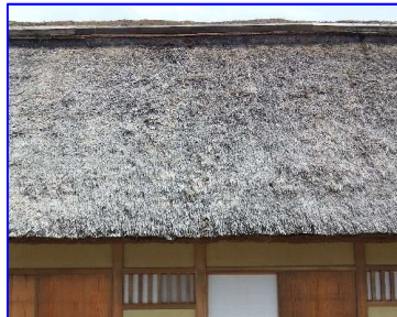
■名勝楽山園拾九間長屋草棟(くれぐし)修繕(令和4年3月28日) 国指定名勝楽山園保存管理計画に基づき、老朽化が見受けられた箇所を修繕を実施した。
