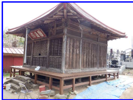
■天引新屋地区の圓通閣 圓通閣は古くから安産の神として地域住民の信仰を集めている観音堂である。維持管理を行っている仁井屋組住民の協力を得て建物の改修工事を行い天引地区の歴史的な建造物として景
