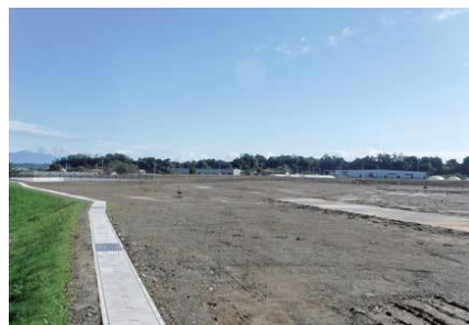
造成を終えた天引第3工業団地
