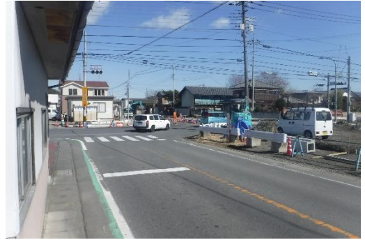
改良工事が進む国道254号福島西交差点
