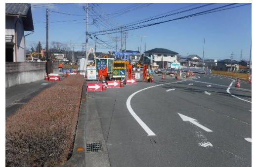
拡幅整備が進む県道金井高崎線
