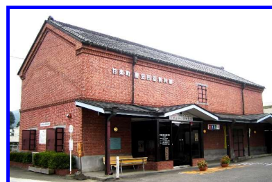
■農業倉庫等として利用された 旧甘楽社小幡組倉庫
