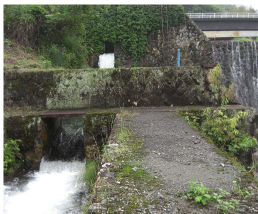
■雄川からの取水口 (大口)
