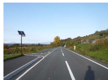
●歩道や街灯が整備された町道
