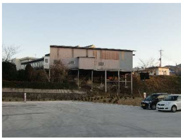
●景観不適合建造物の撤去前
