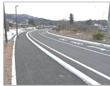
●歩道の付いた町道整備
