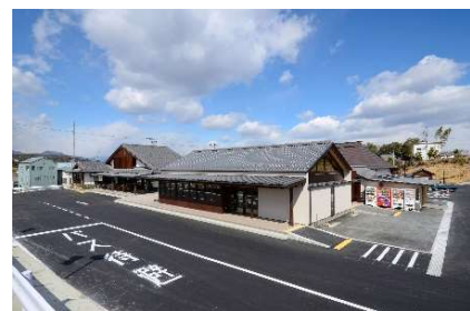
●「道の駅甘楽」の整備後の外観
