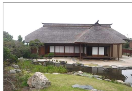
●整備後の屋敷と庭園
