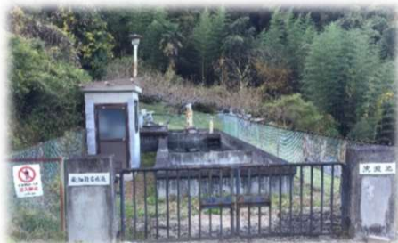
来波浄水場（沈殿池）
