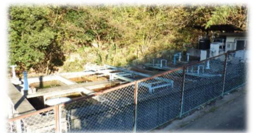
轟浄水場（沈殿池）
