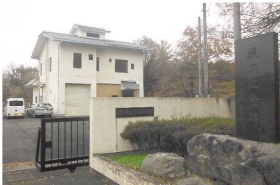
城南上野地区農集排処理施設
