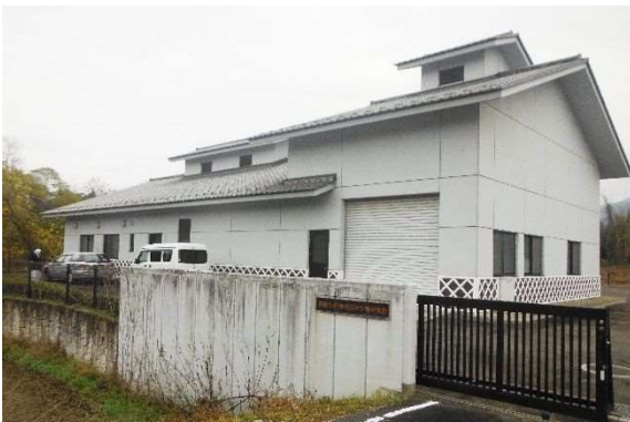
善慶寺・国峰地区汚水処理施設
