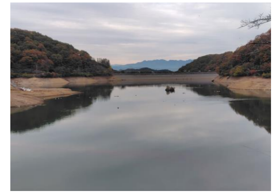
【南側からの全景】
