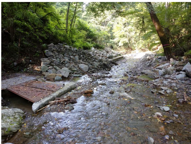
堂の入川水源の取水口
