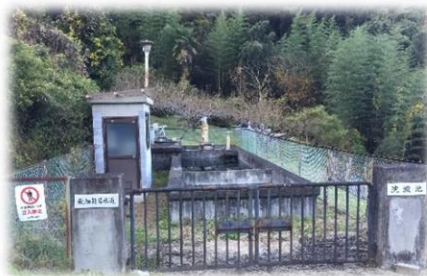
来波浄水場（沈殿池）
