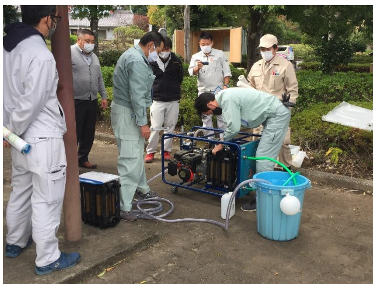
緊急時に備え、災害対策用造水機の操作訓練を実施
