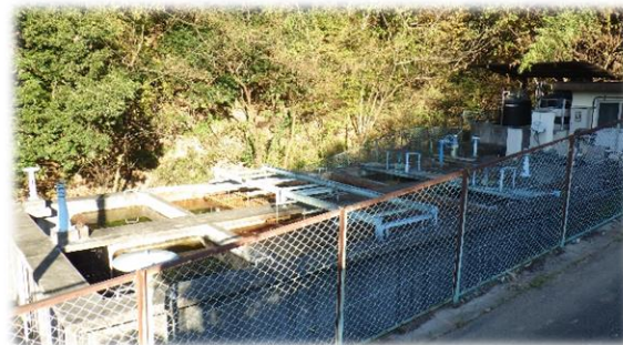
轟浄水場（沈殿池）
