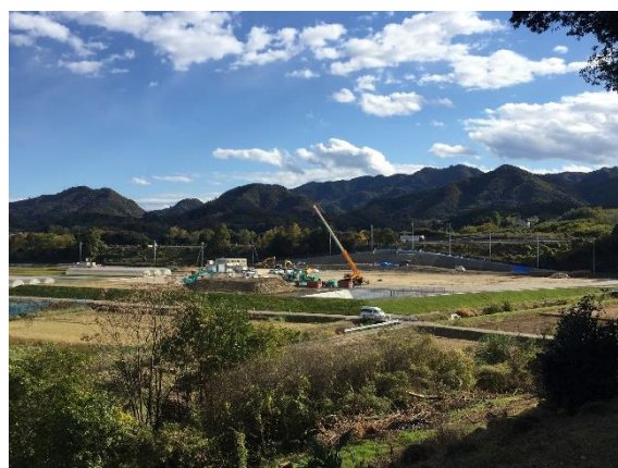
整備が進む天引第三工業団地
