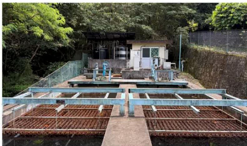
轟浄水場配水池の様子
