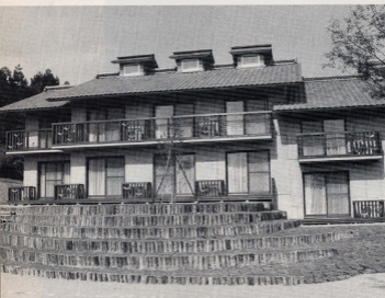
▲鉄筋二階建ての「宿泊棟」。瓦屋根の上には、古い養蚕農家をモチーフにした“天窓”が取り付けられています。客室は、全室テレビ付き、冷暖房完備です。
