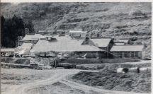
▲4月のオープン目指して、急ピッチで工事が進む「甘楽ふるさと館」
