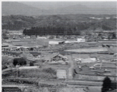
オープンに向け納期に進む工事のようす
