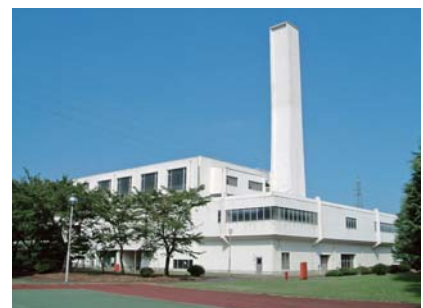
衛生管理センター (し尿処理施設)
