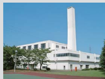
衛生管理センター(し尿処理施設)
