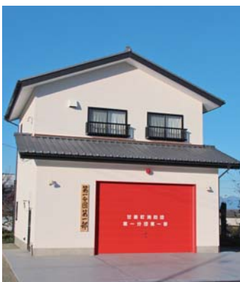
新しい1-1の詰所
