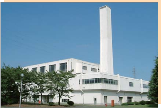
衛生管理センター（し尿処理施設）
