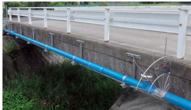
白倉地区の本新川橋に架設された配水管の水管橋
