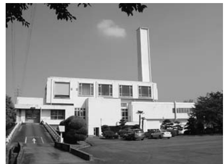
衛生管理センター(し尿処理施設)
