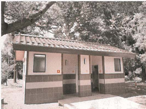
改修された笹森公衆トイレ
