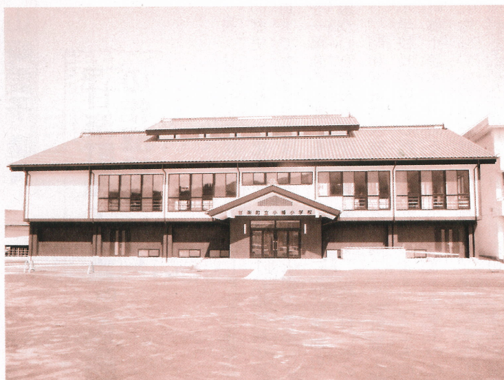
小幡小学校屋内運動場
