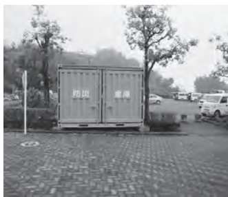
甘楽ふるさと館 駐車場の防災倉庫
