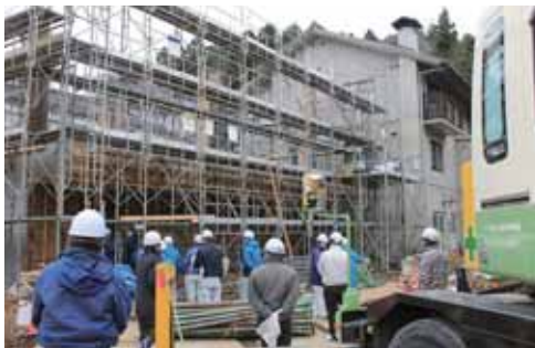
建設中の入浴施設工事現場
